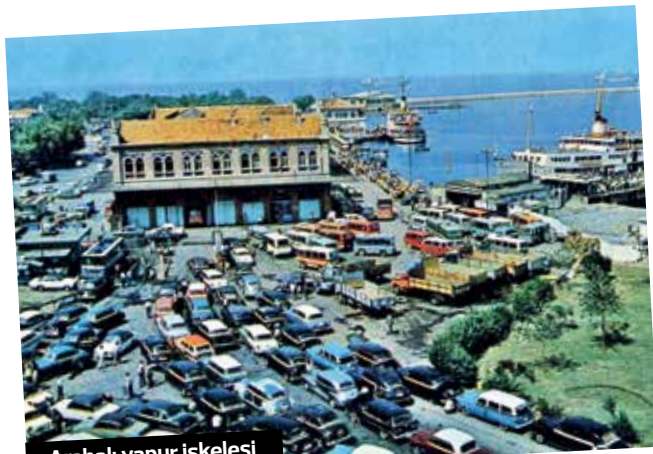
Arabalı vapur iskelesi
